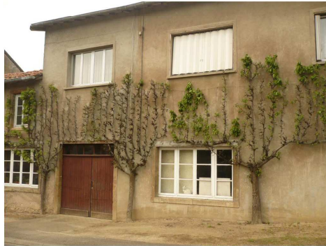
Poirier palissé 53, Grande Rue 1
