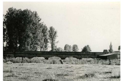
Pont en pierre franchissant le Longeau 34
